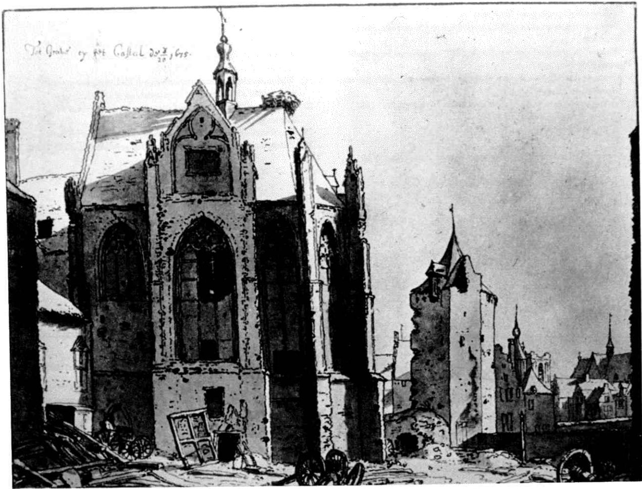
Afb. 3. De kasteelkapel, gezien vanuit het zuiden (Valentijn Klotz, 1675). Aan linkerzijde de grote zaal met kruiskozijnen, voorzien van frontonafdekking. Achter de kapel de hoofdvoelgel, waarin o.m. de kapelkamer en eetzaal. Op de achtergrond de noordoostelijke hoektoren met een traptoren (v. Hasselt, nr. 148, Musées Royaux de Peinture et de Sculpture, Bruxelles , coll. De Grez, inv. nr. 881). Foto: Provinciaal Genootschap voor Kunsten en Wetenschappen, 's-Hertogenbosch.
